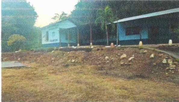
Se observa el peligro por no tener un muro de contención.
