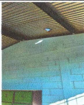
Se observa el deterioro de las laminas con perforación.
