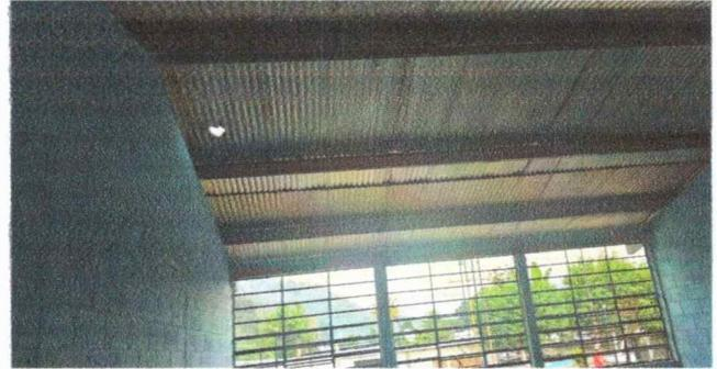
Se observa el deterioro de las laminas y falta de pintura.
